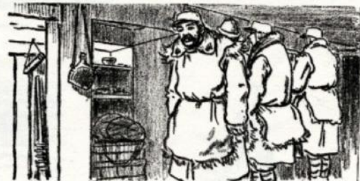
Tranchées à Saint-Waast : Poilus en première ligne, dans une maison organisée
