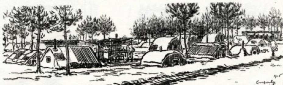
Un cantonnement sous les pins : le "village nègre" de Cuperly
