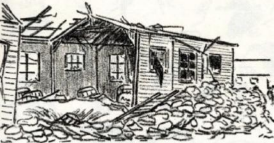
H. O. E. de Courlandon : Baraque de blessés démolie par les bombes d'avions boches
