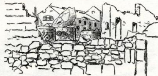
Faubourg Saint-Waast : la distillerie
